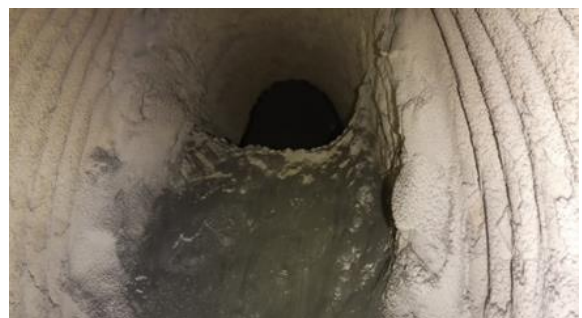
<ELIOS 2により、発生ガス管内部を撮影>
