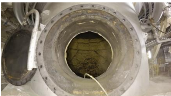
<ELIOS 2により、設備の入り口を撮影した画像>
