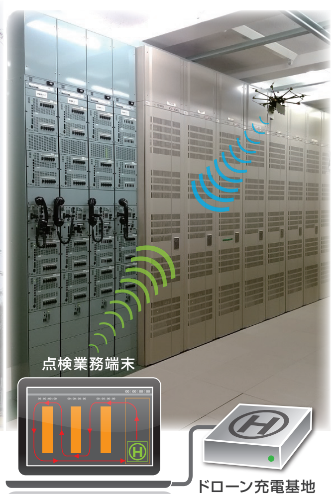
屋内点検用ドローン (イメージ)
