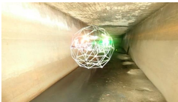
&lt;下水道管渠内の奥 70m 先へ進む ELIOS2&gt;
