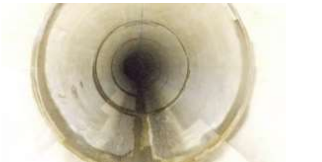
<駅付近の地下空間(雨水管)光ファイバー回線の配線>
