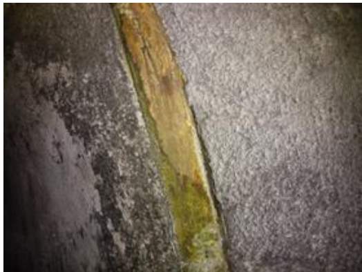
<②ダクト内部のつなぎ目の状態>
