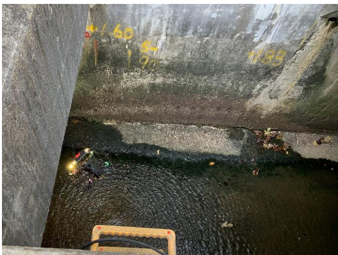
<雨水管渠内に進入する ELIOS2>
