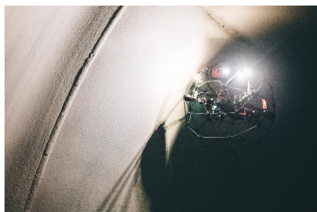
ELIOS 2による点検風景
